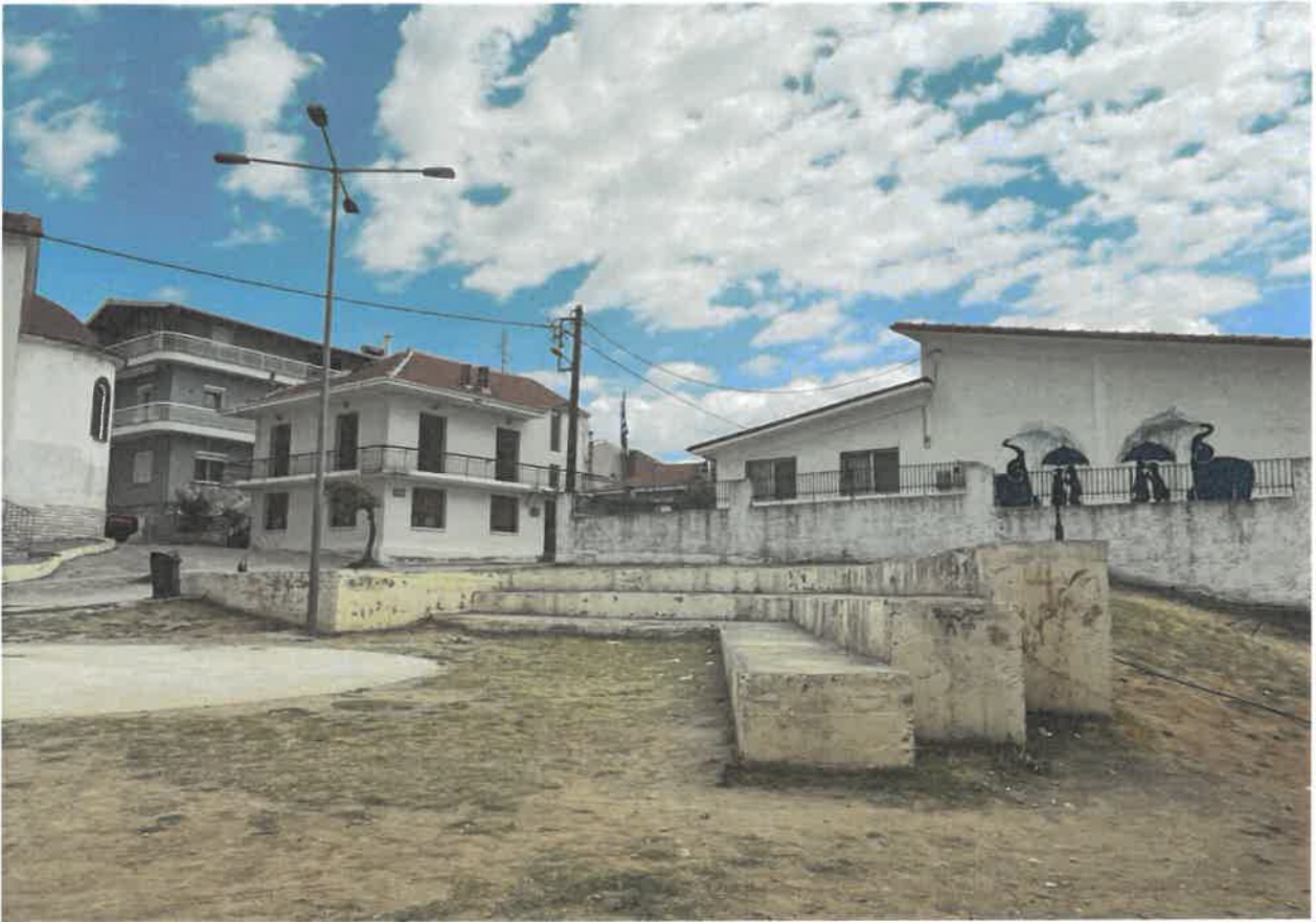
ΦΩΤ.2 Λήψη των υφιστάμενων κερκίδων της «πλατείας»
